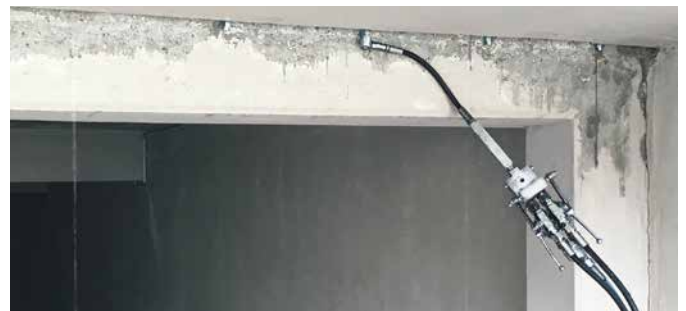
Injektion bauchemischer Füllstoffe | Injection de matériau chimique de bâtiment
